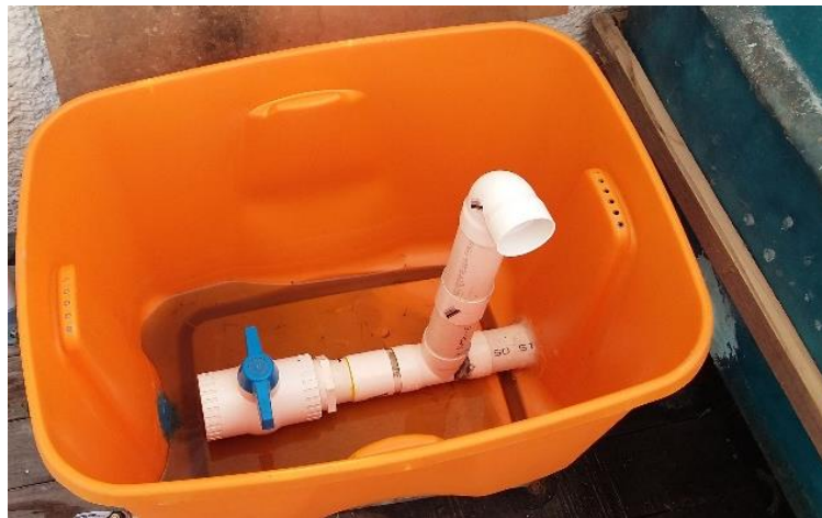
Figura 6. Dispositivo de control de nivel de agua y válvula para vaciado del sistema.
